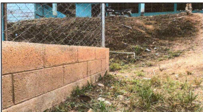
Foto 3: Construccion de muro perimetral
