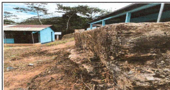
Foto 6: Construccion de muro perimetral
