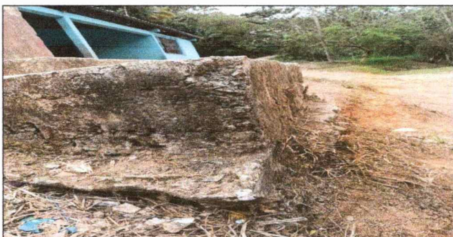
Foto 5: Construccion de muro perimetral
